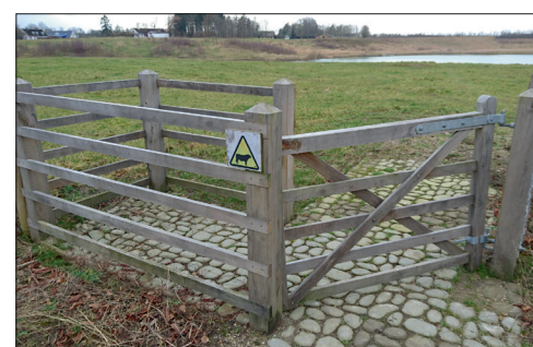
Hier befindet sich das Gatter in Position 2. In dieser Position wird das Tor mit einer einzigen Torfalle festgehalten.
