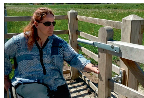
Das Gatter wird aus Position 1 in Position 2 geöffnet. Das Gatter ist selbstschließend, sodass es niemals halb offen stehen kann.
